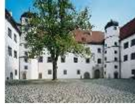
HöS.I, Schloss Höchstädt, Innenhof, Blick von Osten auf West-Trakt, DE001257, BSV
