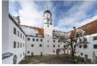
HöS.I, Innenhof mit Blick auf die Schlosskapelle, DI021473, BSV-
